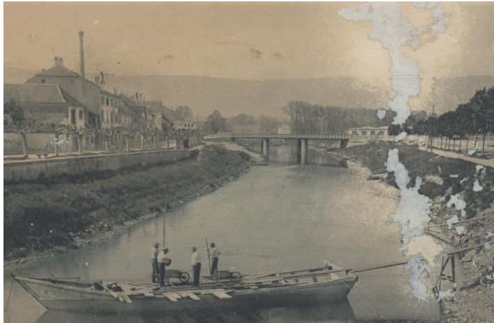
Fig. 11 Fig. 6 Le quai de la Thièle ; à gauche, la rangée de maisons où habitent les Decoppet vers 1900 1900
